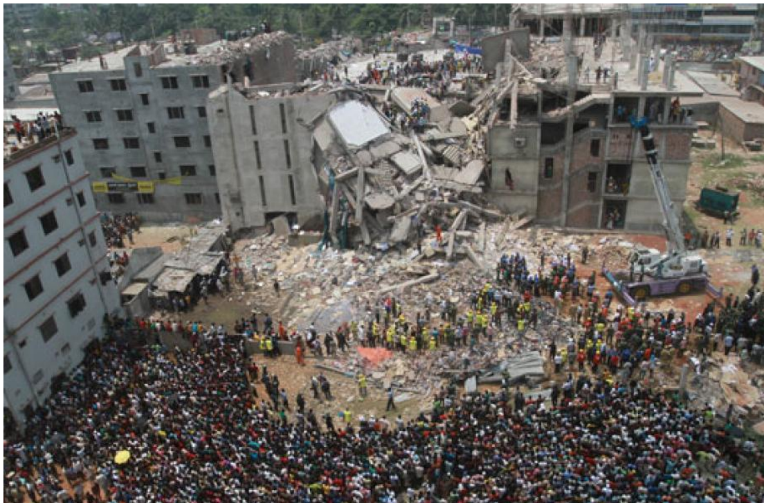
Figura 3 - Desabamento do edifício Rana Plaza.
