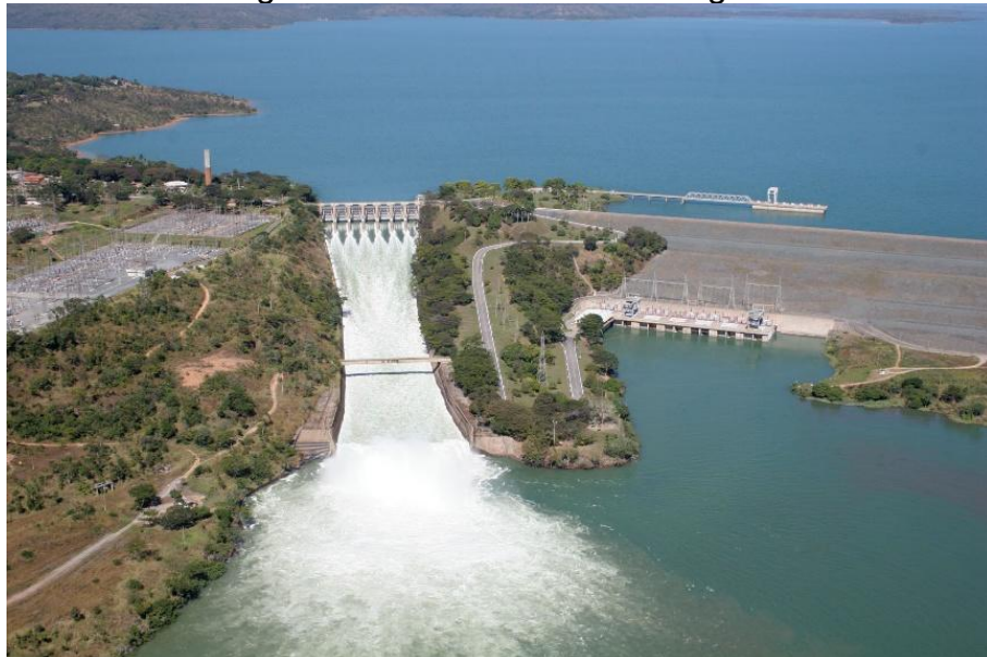
Figura 8 - Reservatório e Barragem
