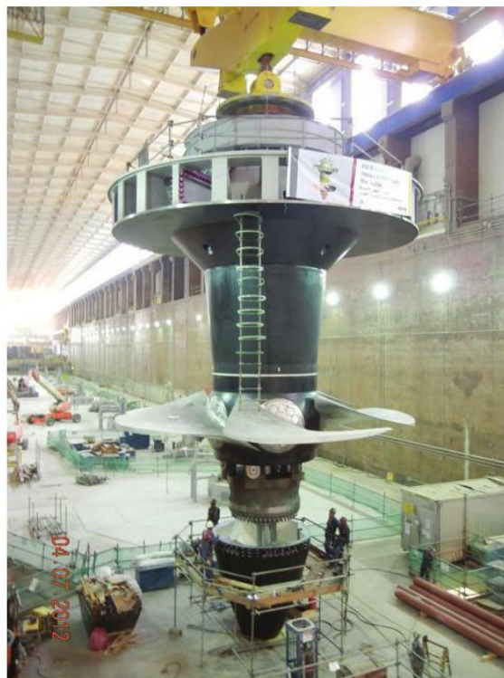
Figura 16 - Turbina Kaplan
