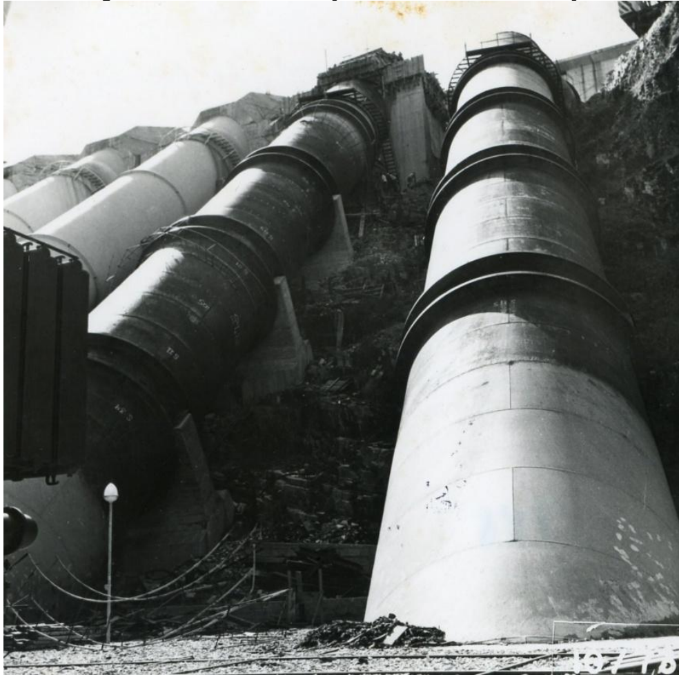
Figura 10 - Condutores Forçados e Sistema de Adução
