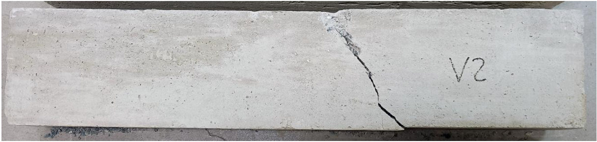
Figura 37. Viga sem reforço V02
