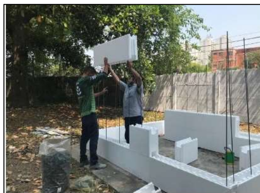
Figura 8 - montagem das formas ICF (segunda fiada).
