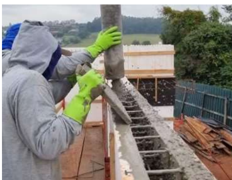
Figura 9 - Concretagem das formas de ICF
