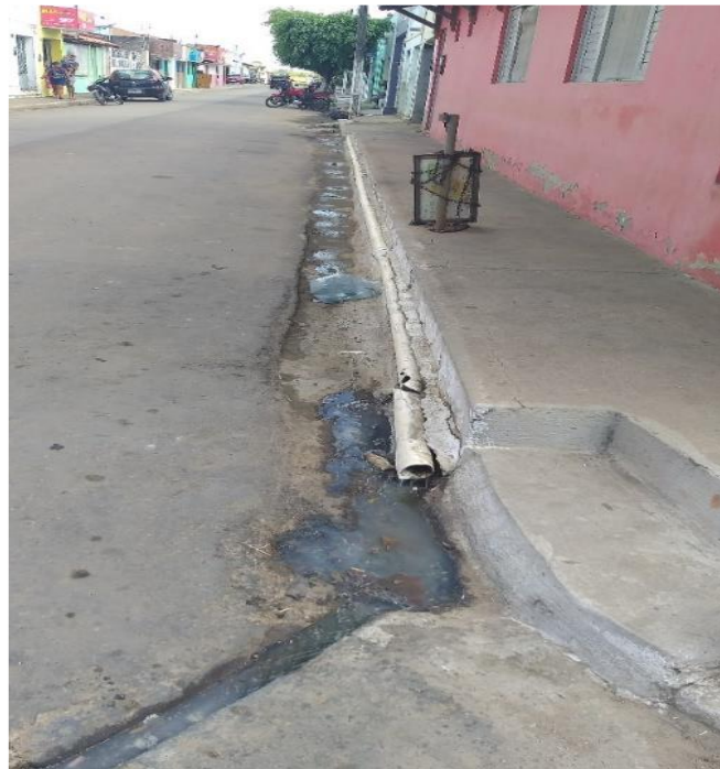
Figura 8: escoamento de água servida de um restaurante no centro
