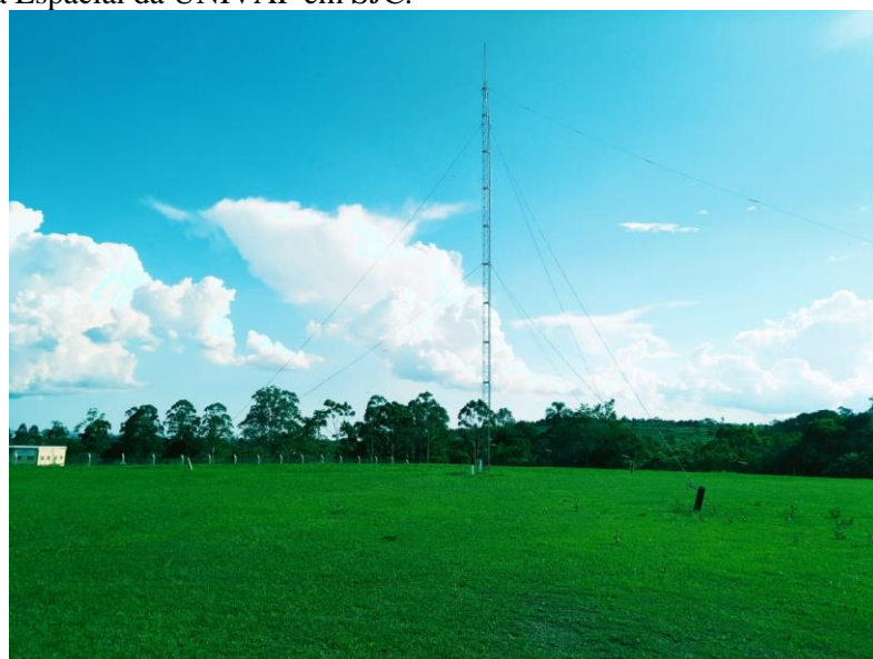
Figura 24 - Antena delta com um mastro de aproximadamente 20 metros localizada no observatório de Física Espacial da UNIVAP em SJC.
