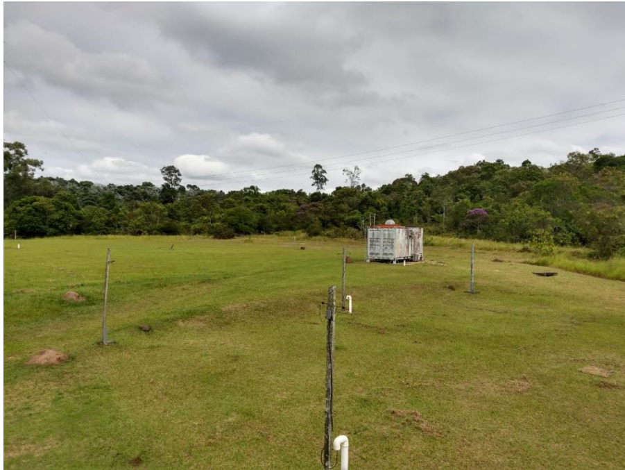
Figura 9: Antena de recepção e vista do container onde estão instaladas o computador de monitoramento e armazenamento dos dados da ionossonda.
