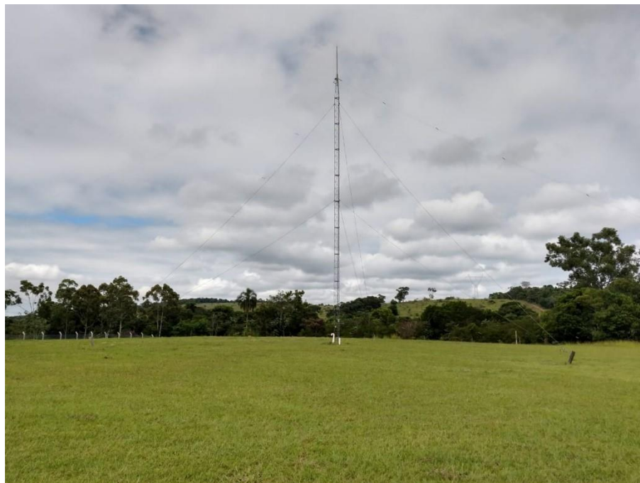
Figura 8: Antena Delta utilizada na transmissão de sinais da ionossonda localizada no campus Urbanova da UNIVAP em São José dos Campos.
