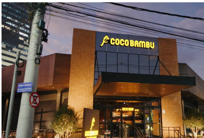
Figura 26: Fachada do restaurante Coco Bambu.
