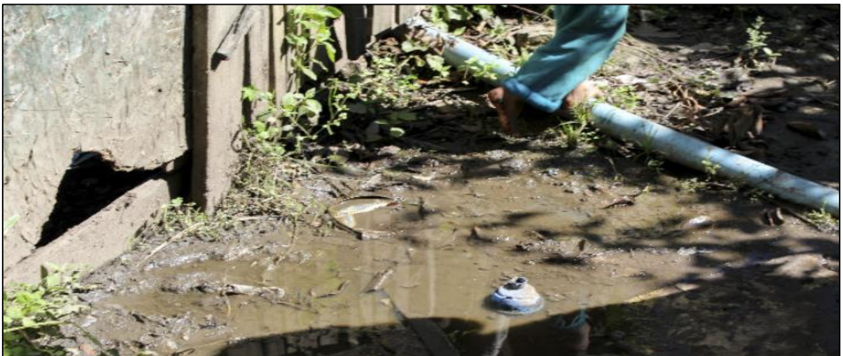
Figura 4: Falta de saneamento no Jardim Nova Esperança
