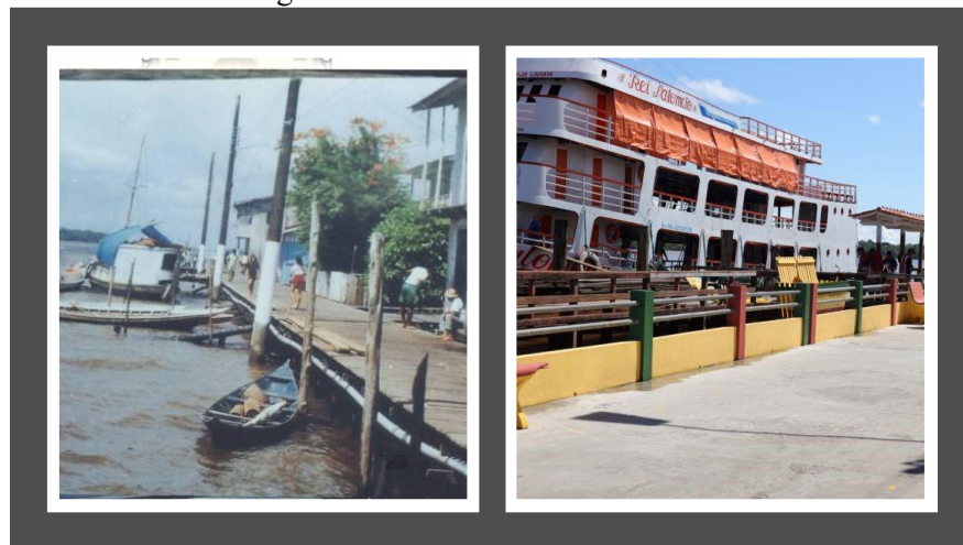
Figura 18 - Rua Barão do Rio Branco
