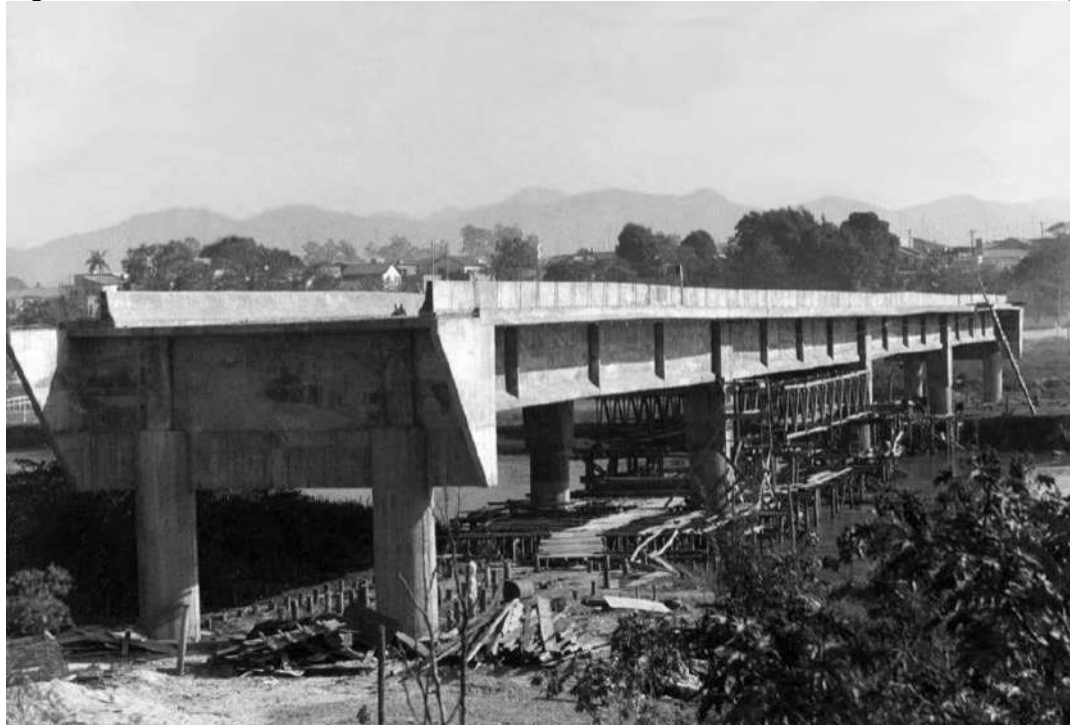
Figura 30: Ponte de acesso ao bairro Vila Menino Jesus sobre o Rio Paraíba do Sul em Caçapava/SP.
