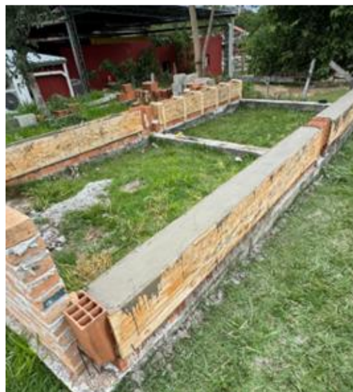
Figura 16 - Fôrma finalizada com espaçamento de 0,8m
