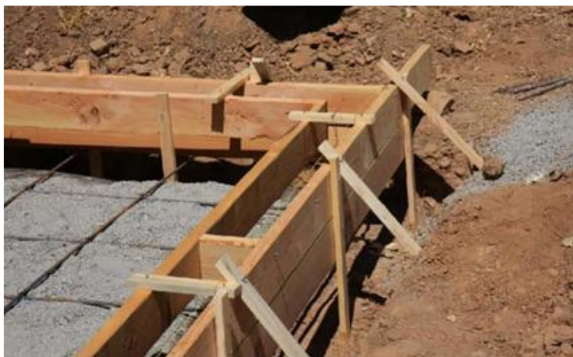
Figura 2 – Escoras responsáveis pela fixação das fôrmas de madeira.
