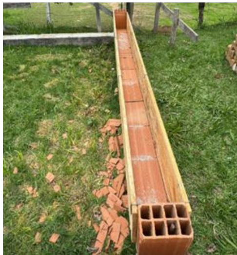
Figura 12 - Fôrma finalizada com espaçamento de 1 m entre os grampos metálicos.
