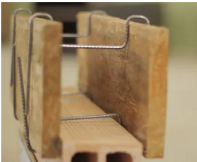
Figura 7 – Fixação da fôrma para concretagem com grampos
