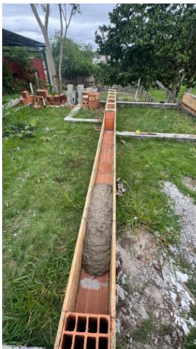
Figura 8 – Fôrma finalizada utilizando espaçamento de 0,6 m entre os grampos metálicos.
