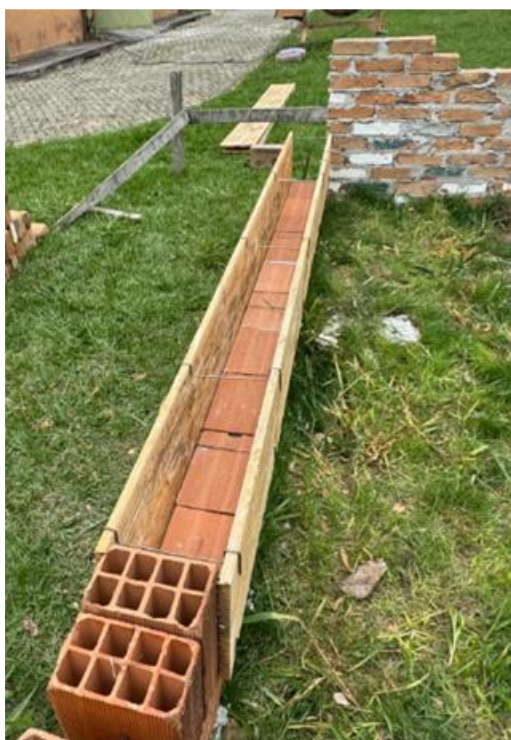
Figura 11 – Fôrma montada com espaçamentos de 0,8 m entre os grampos.
