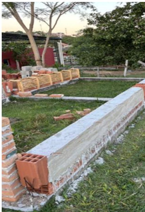
Figura 19 – Viga concretada com espaçamento de 0,8 m
