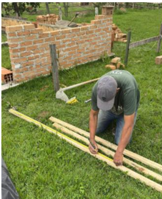
Figura 9 – Medição e corte das ripas de 0,05 m de altura
