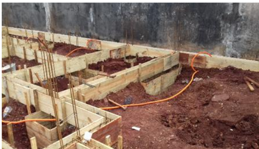
Figura 3 – Predominância da madeira em fôrmas (obras menores)
