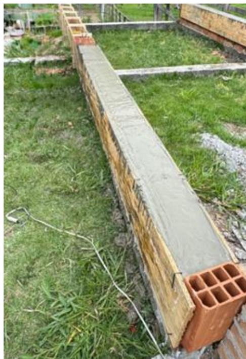
Figura 14 – Fôrma finalizada com espaçamento de 0,6 m entre os grampos metálicos finalizada
