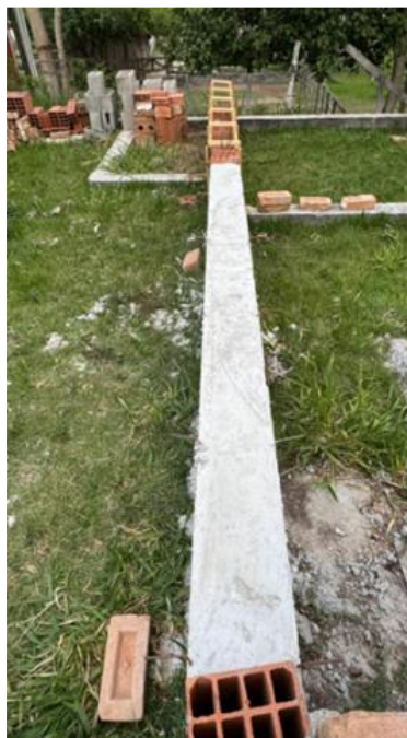
Figura 18 - Viga concretada com espaçamento de 0,6 m entre os grampos metálicos.
