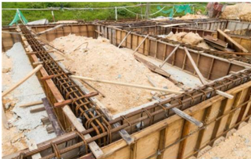
Figura 6 – Fôrmas de madeira em processo de montagem com pregos, arames e sarrafos
