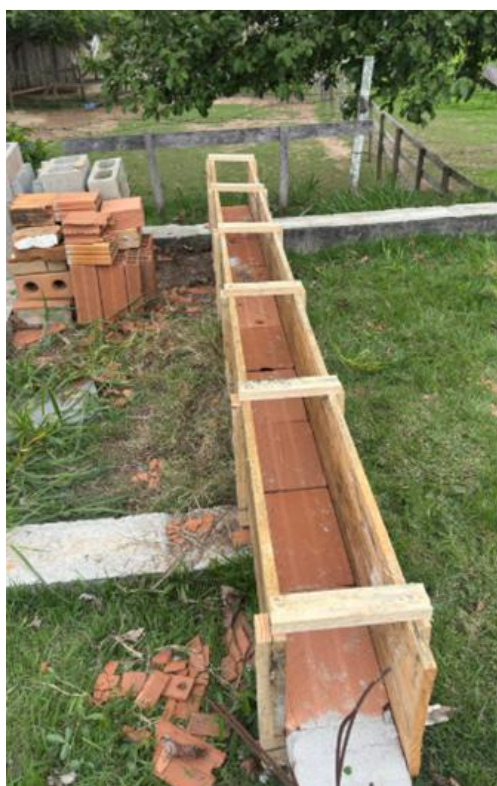
Figura 10 – Fôrma montada com espaçamento de 0,6 m (Método convencional)
