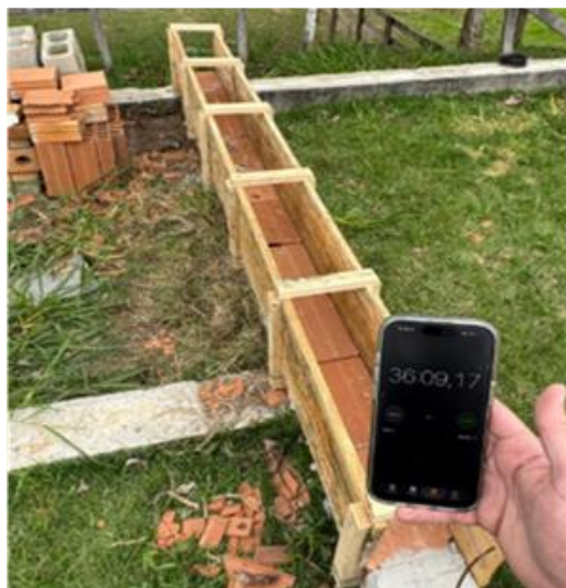
Figura 15 - Tempo de montagem da fôrma com espaçamento de 0,6 m utilizando o método convencional
