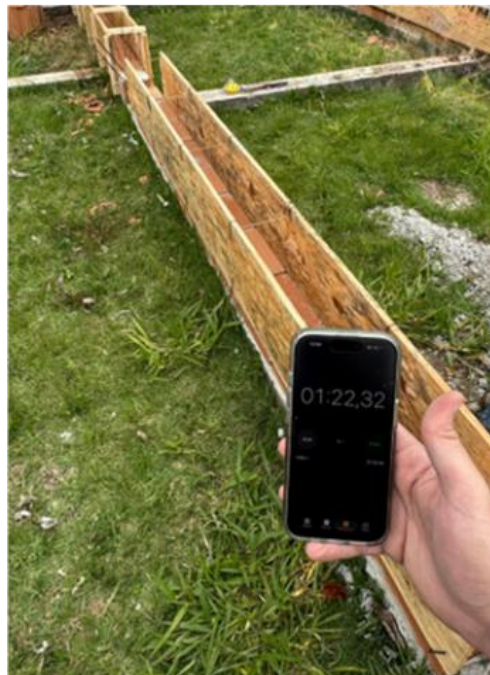
Figura 13 – Tempo de montagem da fôrma com espaçamento de 0,6 m utilizando o método com grampos
