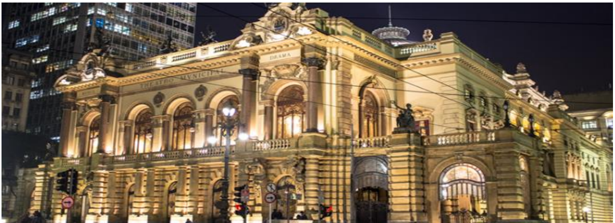
Figura 18 - Teatro Municipal SP (Arquiteto Ramos de Azevedo)
