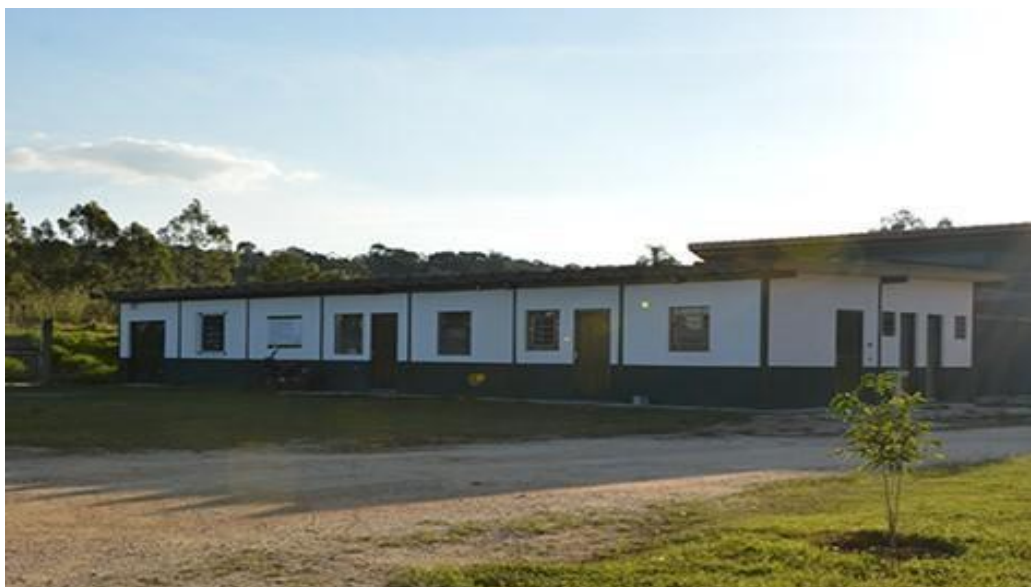
Figura 2 - Vista do prédio da quarentena do CRAS da Universidade do Vale do Paraíba – UNIVAP.
