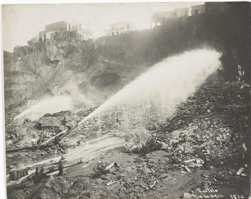
Figura 23. Uso de jato d'água para derrubar o morro do Castelo.
