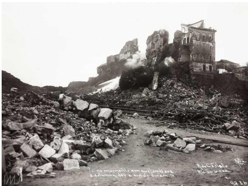
Figura 24. Demolição do Morro do Castelo, jato d'água e explosão de dinamites.
