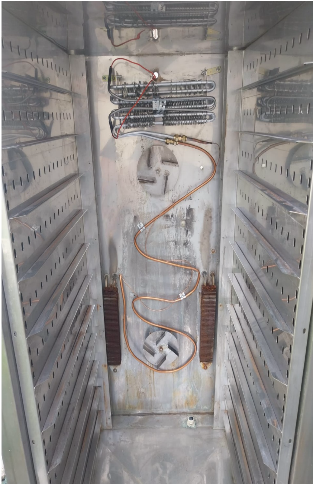
13. Figura 13: Sistema de Refrigeração novo instalado
