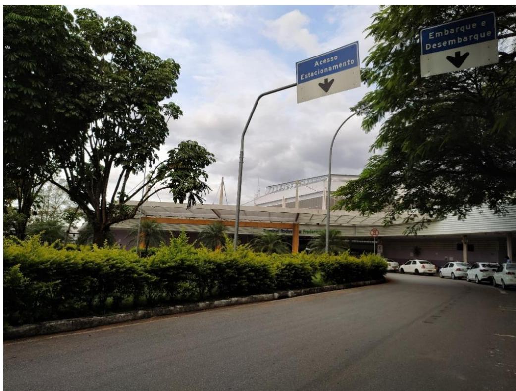
Figura 19 - Entrada do Terminal Rodoviário Intermunicipal Frederico Ozanan – “Rodoviária Nova”.
