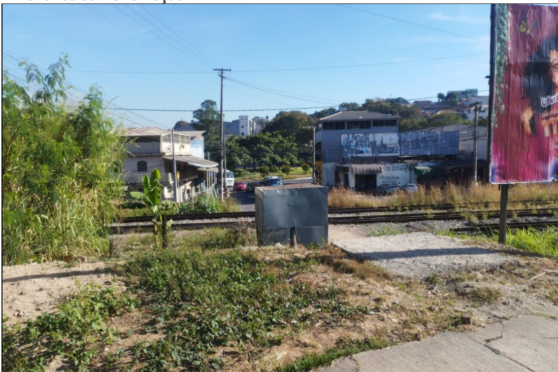
Figura 46: Bairro Parque Jardim Terezópolis – Regional Terezópolis – Passagem em trecho de linha férrea sem sinalização.
