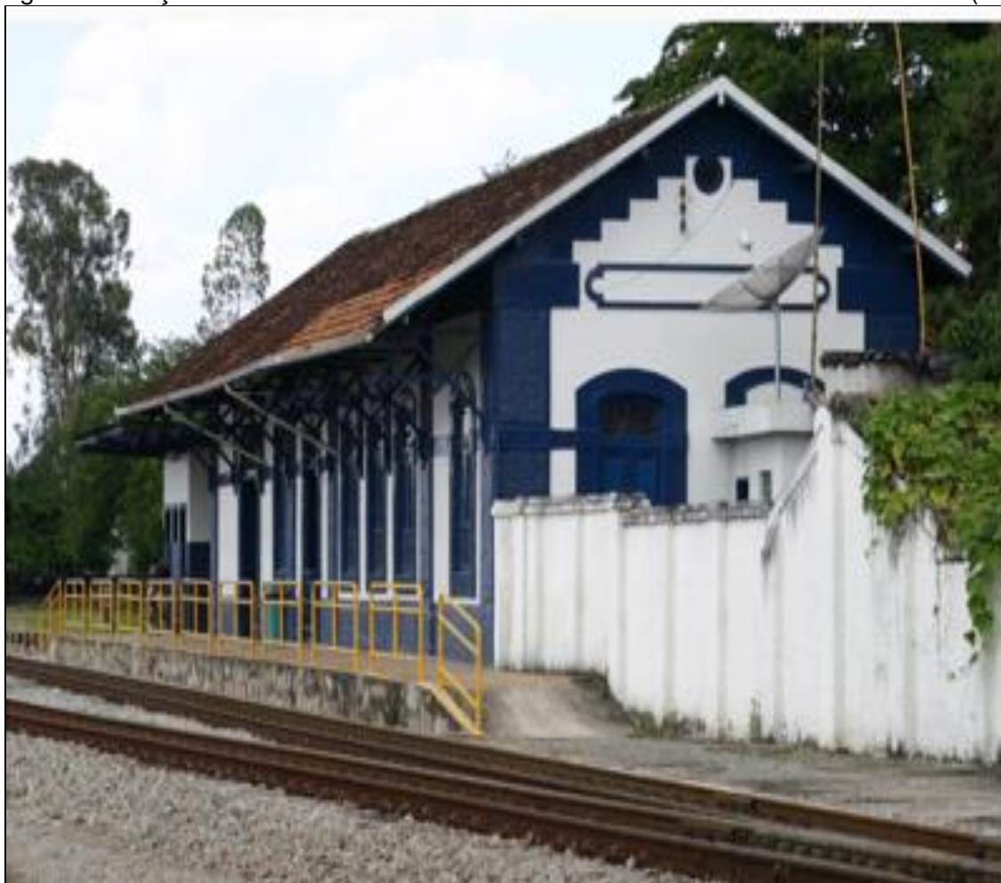
Figura 5: Estação ferroviária da Estrada de Ferro Oeste de Minas concluída em 1910 (atual)
