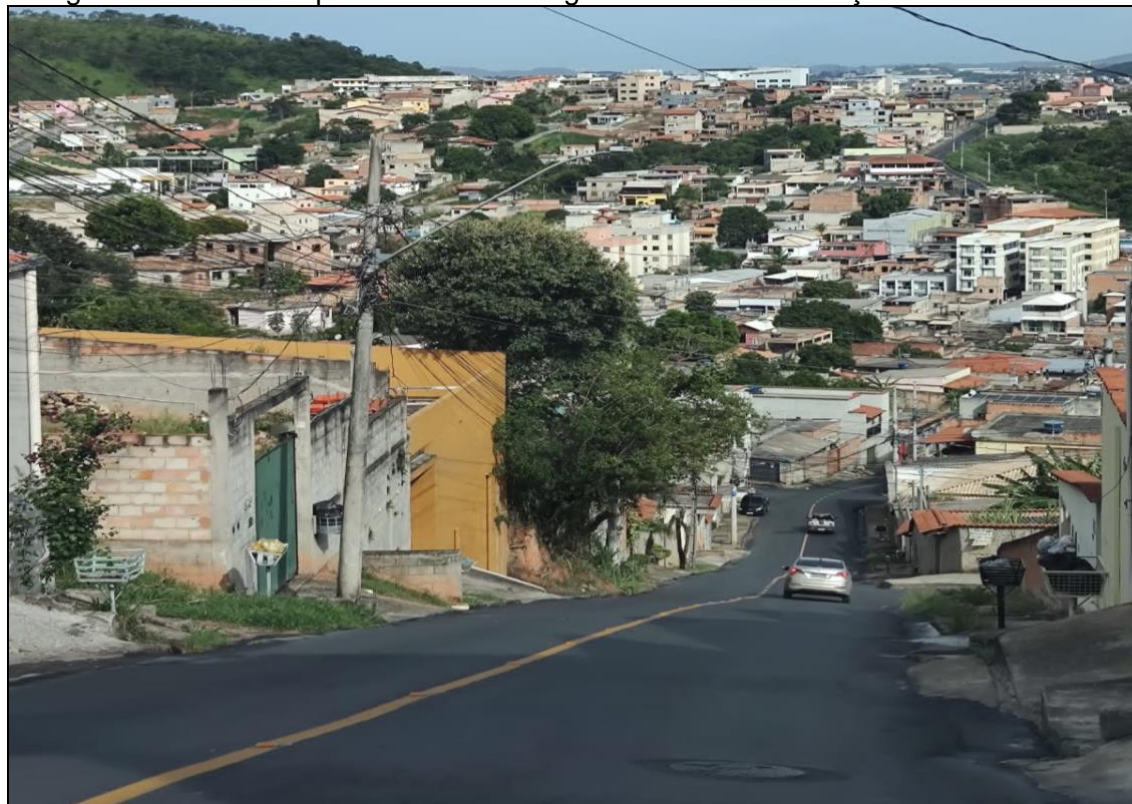
Figura 36: Bairro Duque de Caxias – Regional Alterosas – Calçadas desniveladas
