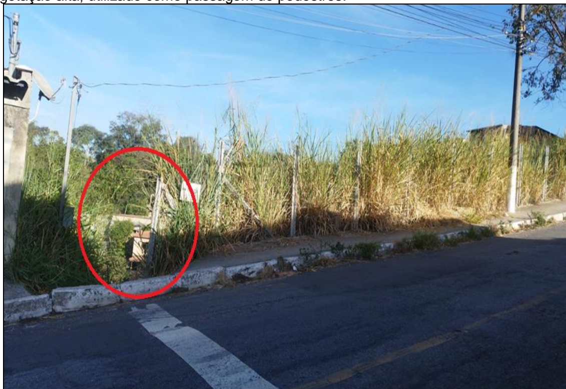
Figura 30: Bairro São João – Regional Sede – Trecho de descida sem iluminação e com vegetação alta, utilizado como passagem de pedestres.
