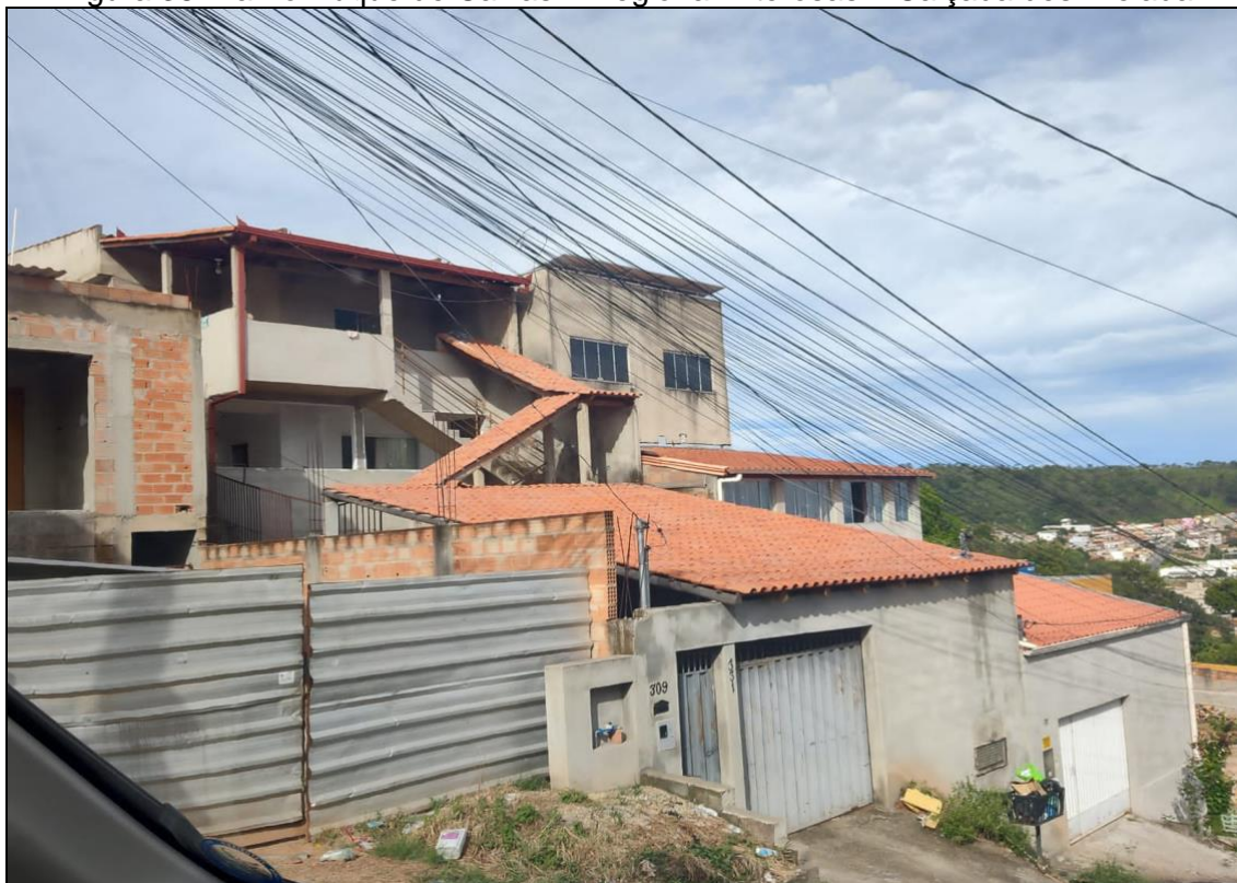
Figura 38: Bairro Duque de Caxias – Regional Alterosas – Calçada desnivelada
