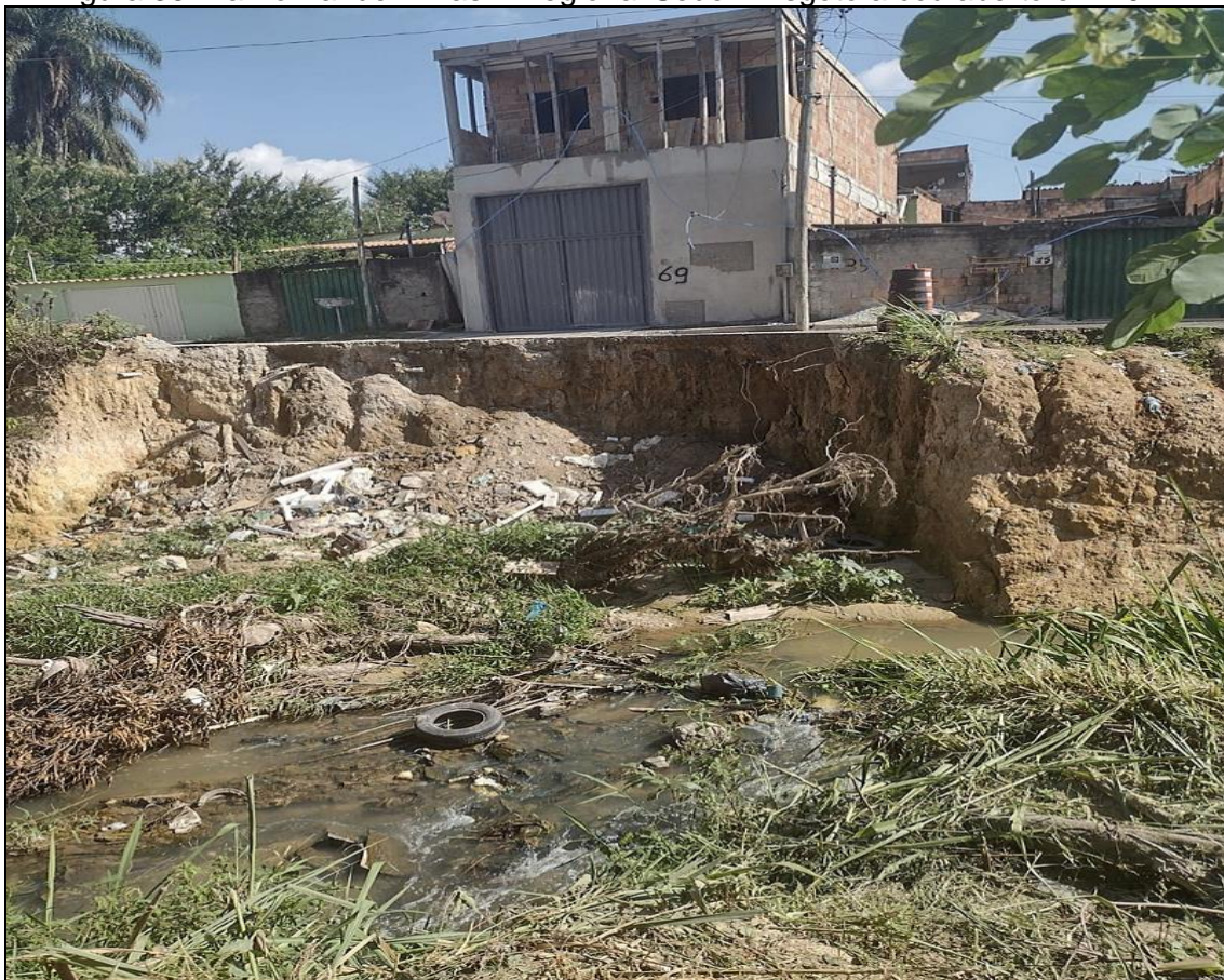
Figura 33: Bairro Bandeirinhas – Regional Sede – Esgoto a céu aberto em 2022.
