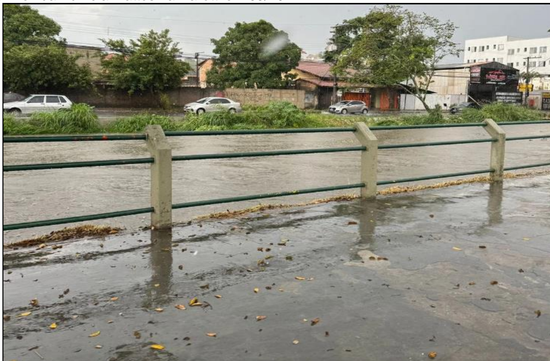
Figura 39: Bairro Jardim Brasília – Regional Alterosas – Trecho de alagamento do Rio Betim na Avenida Edméia Mattos Lazzarotti em 03/2024
