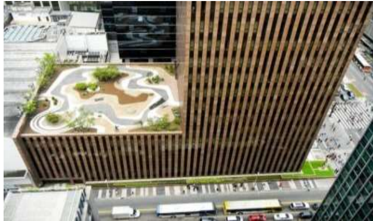
Figura 3 – Telhado verde no Banco Safra em São Paulo.
