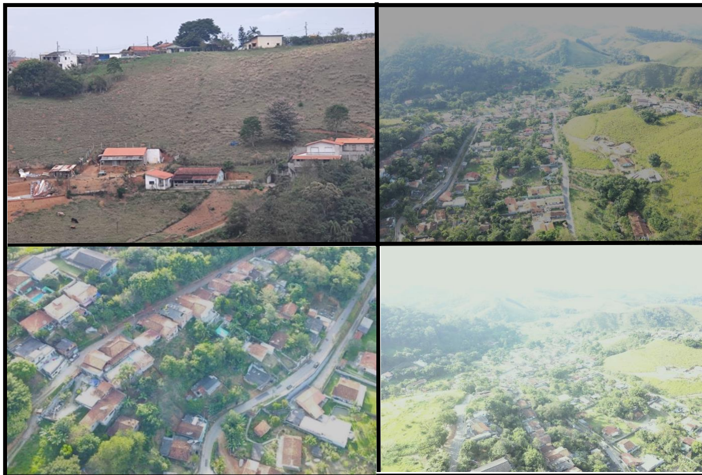
Figura 3 Processo de modificação de encostas e casas em área de risco (imagens obtidas por drone).
