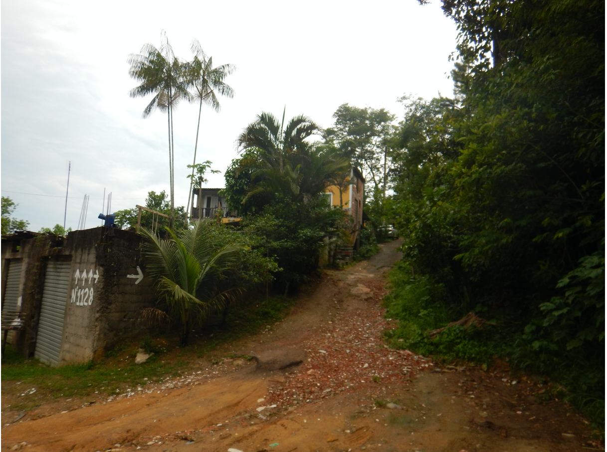
Figura 42 – Moradias próximas à área de preservação ambiental (Bairro Rio do Ouro, Caraguatatuba).
