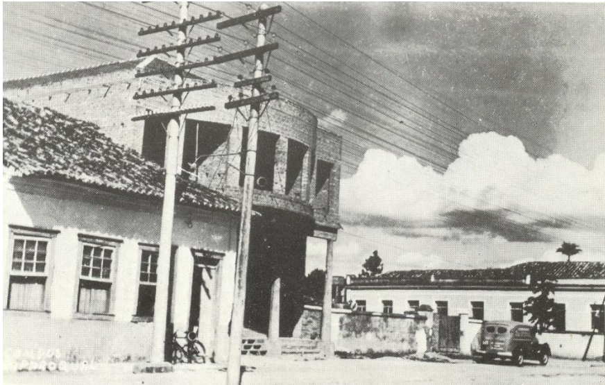
Figura 6: Construção do Salão Paroquial (1946). Foto: Arquivo Público
