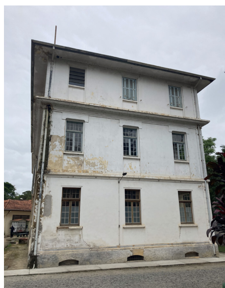
Pavilhão Central Vista Lateral
