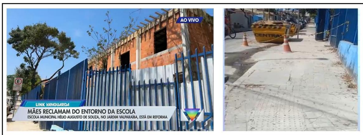
Figura 24 – Obras no entorno de escola
