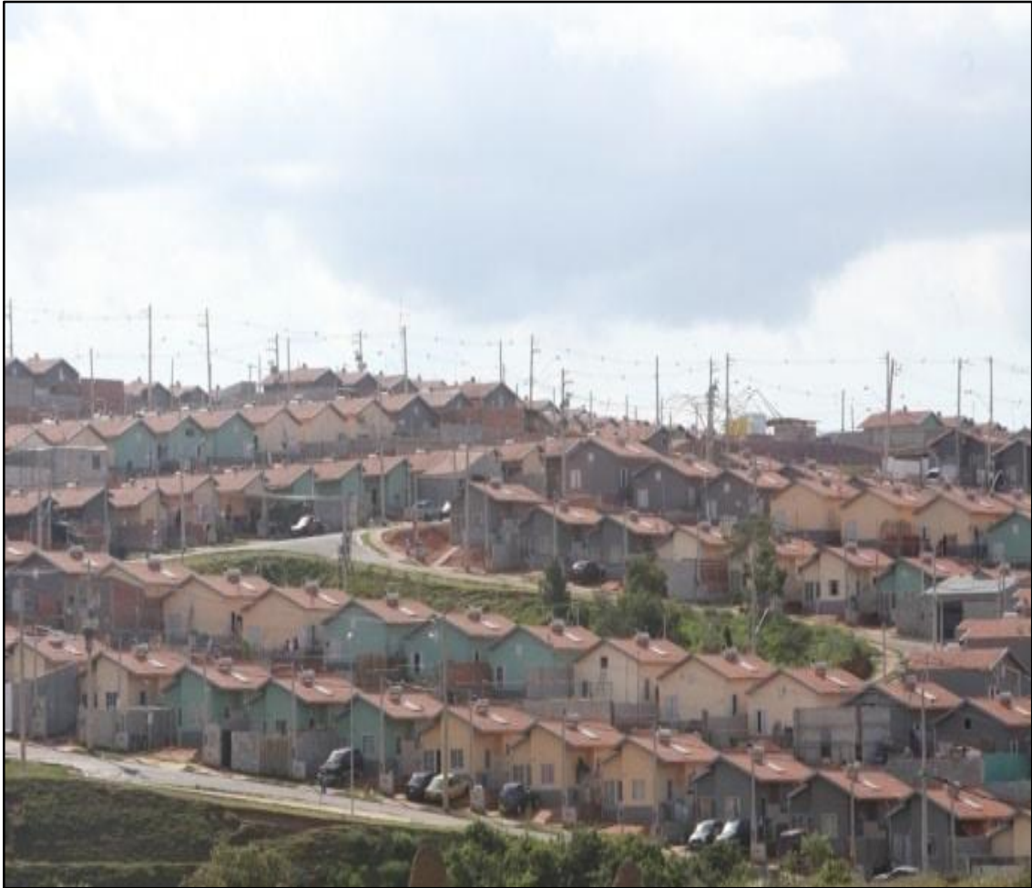
Figura 13 - Fachada do empreendimento Pinheirinho dos Palmares, 2019
