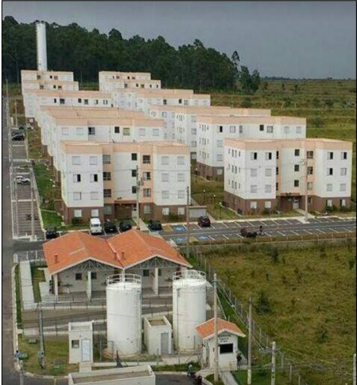
Figura 12 - Fachada do empreendimento Condomínio Residencial Cajuru III, 2019
