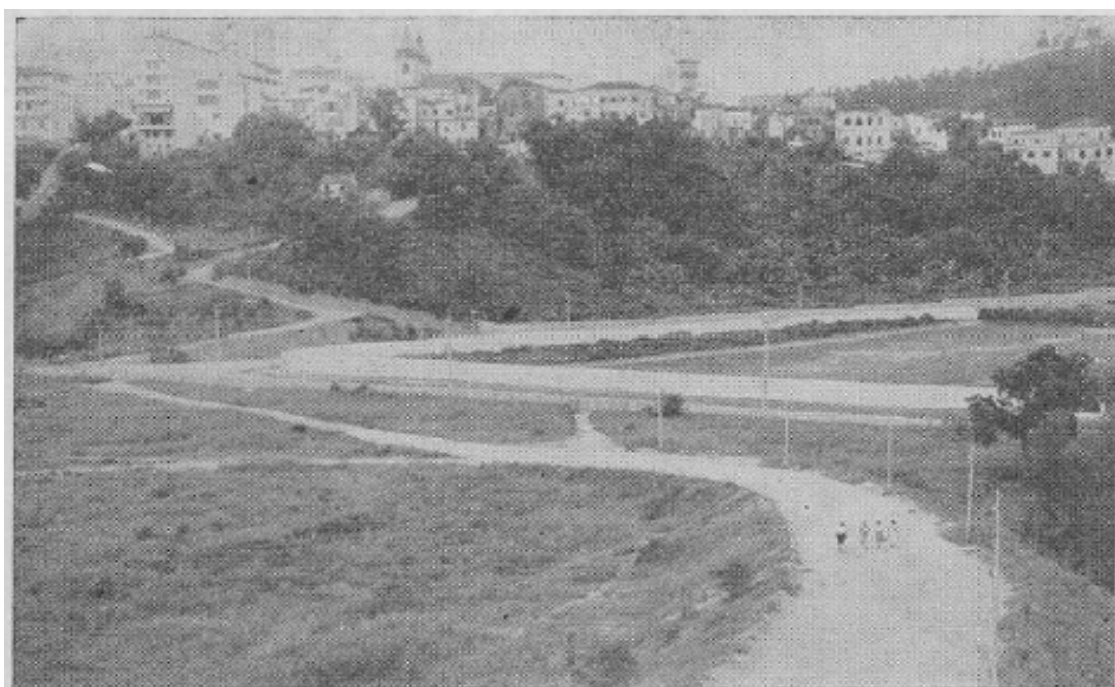
Aparecida — A parte central da cidade, a mais antiga, tem sítio em acrópole, ocupando colina rochosa terraceada, afogada por muito material de desmoronamento. Originalmente a salvo de inundações, a cidade viu-se obrigada, ao crescer, a ocupar a várzea, tendo-o feito, originalmente, ao longo da estrada de ferro. Mas recentemente, novos loteamentos surgem em direção à rodovia Dutra, aspecto que se vê em primeiro plano. (Fot. N. L. Müller 1961).
