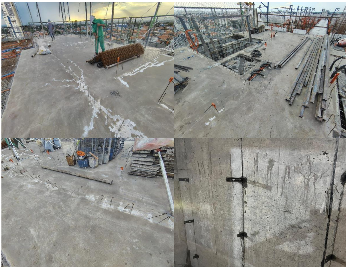
Figura 23 – Cura do concreto autoadensável laje
