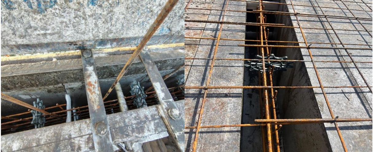
Figura 18 – Espaçadores entre formas
