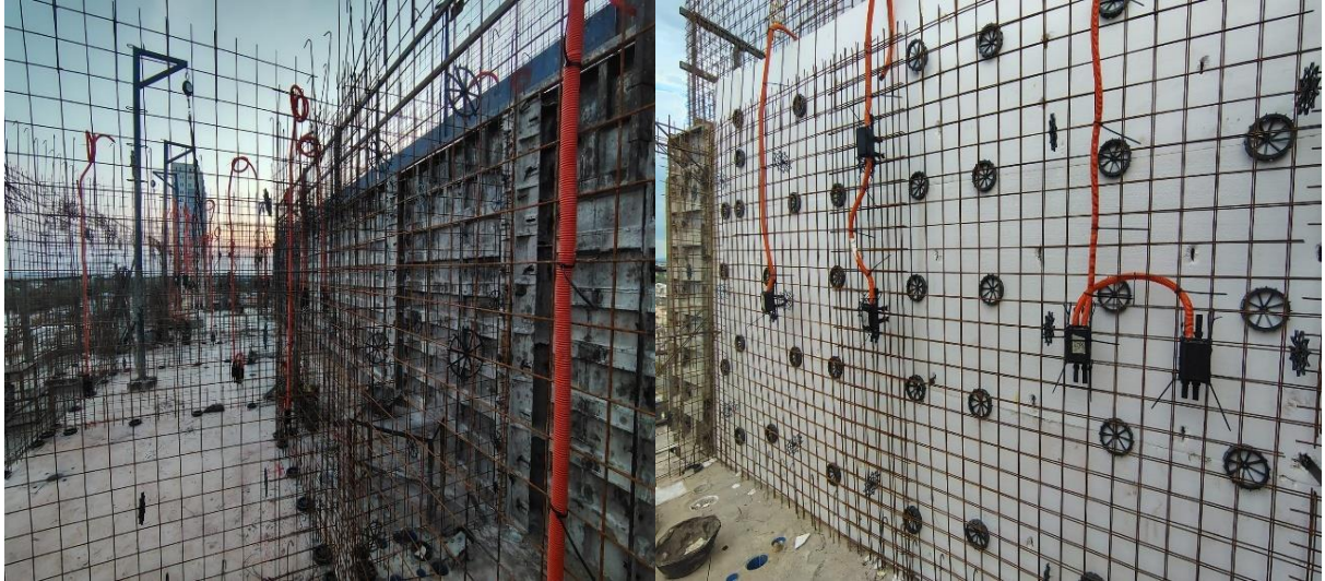
Figura 9 – Passagem da infraestrutura elétrica.
