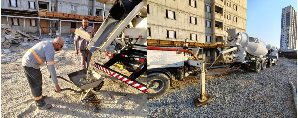
Figura 13 – Descarga do concreto
