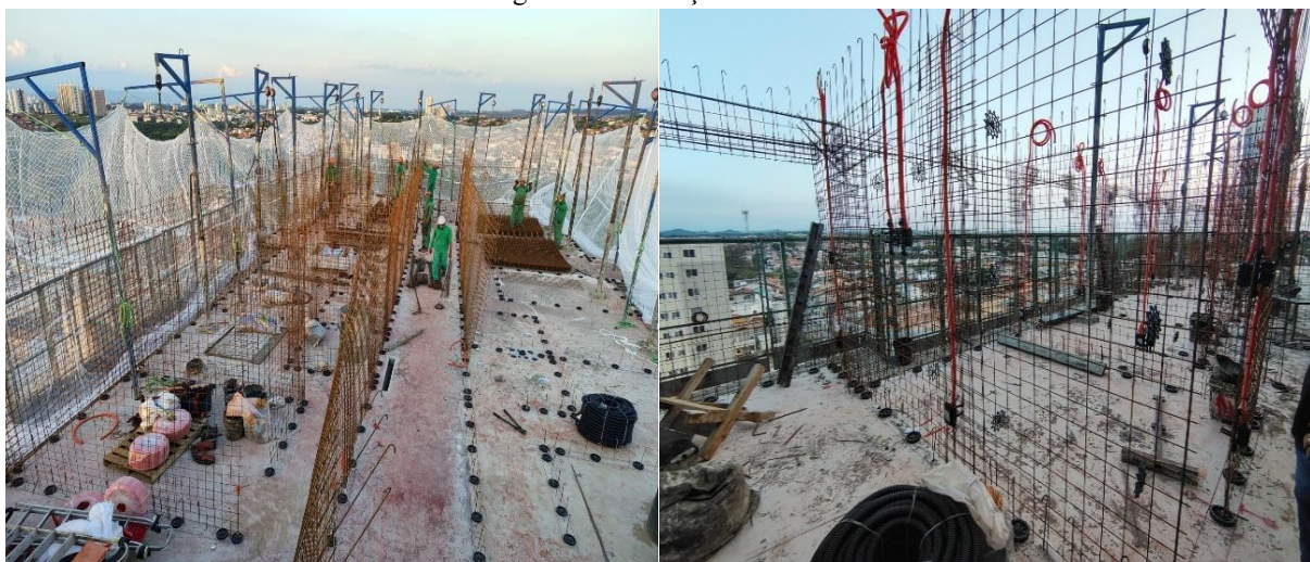
Figura 7 – Instalação das telas
