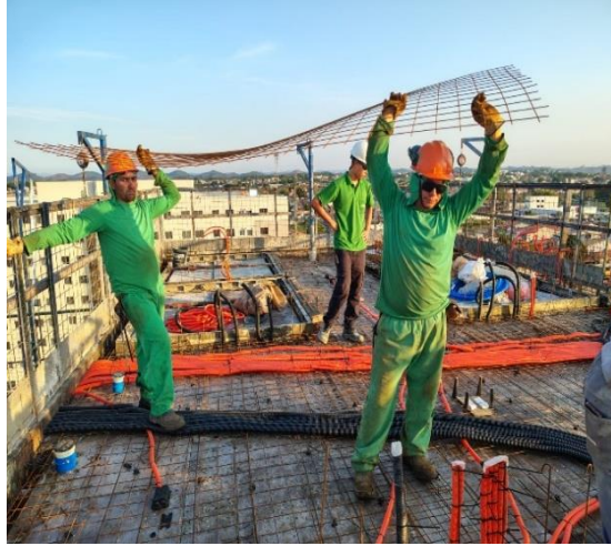
Figura 20 – Instalação das malhas pop na laje
