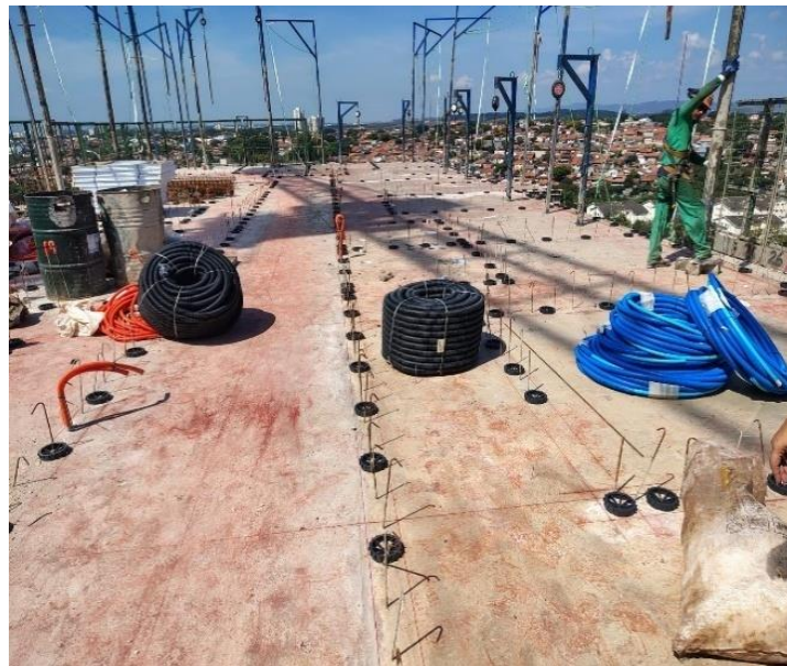
Figura 6 – Marcação das Paredes
