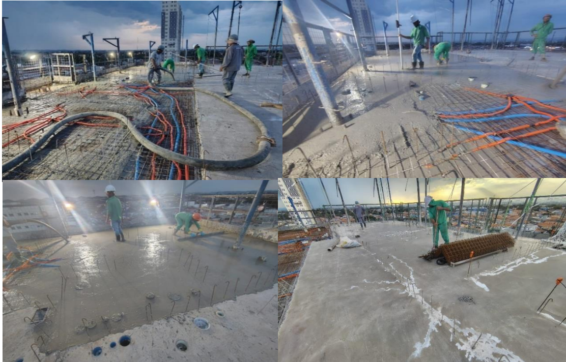
Figura 22 – Concretagem da laje
