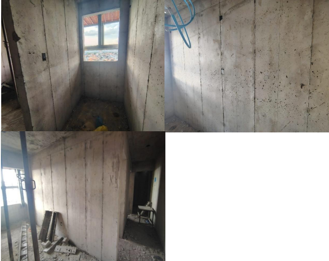
Figura 11 – Desforma das paredes
