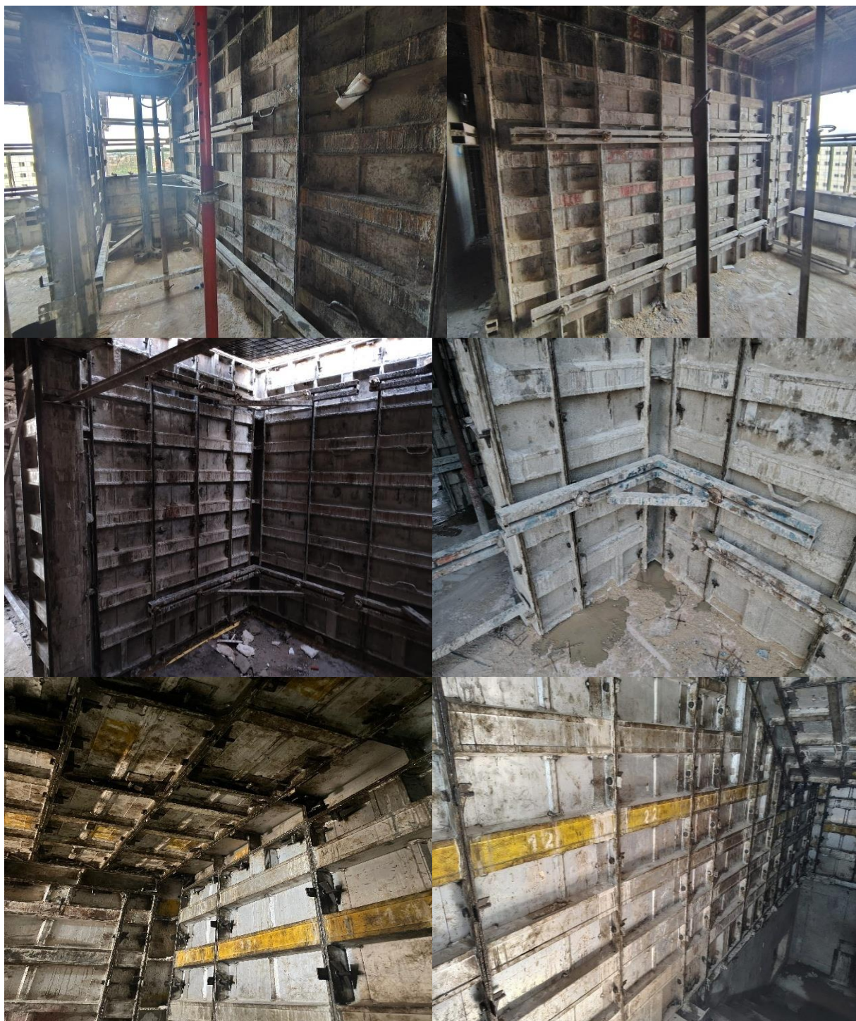
Figura 10 - Fechamento com formas metálicas
