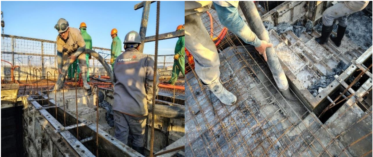
Figura 17 – Transporte do concreto até o local espaçadores
