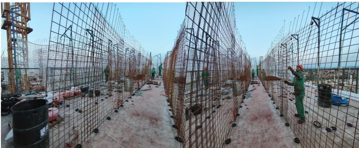
Figura 8 - Instalação das telas e espaçadores
