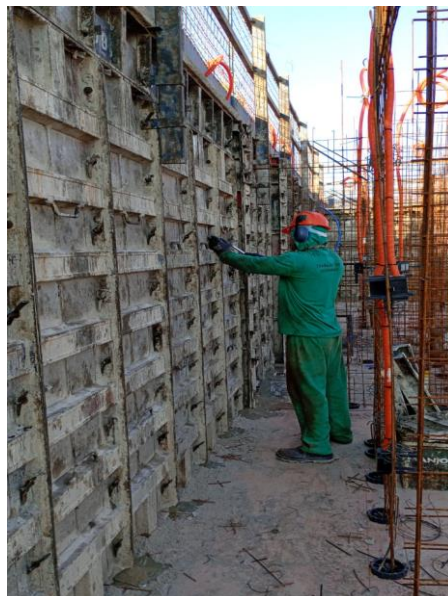
Figura 19 – Lançamento do concreto
