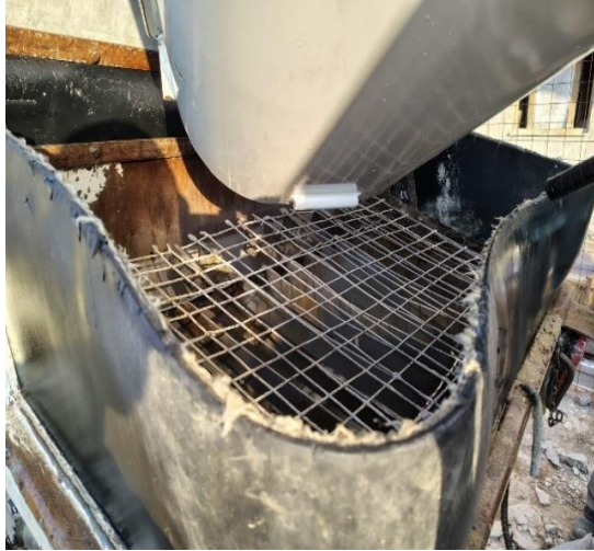
Figura 16 – Peneiramento do concreto
