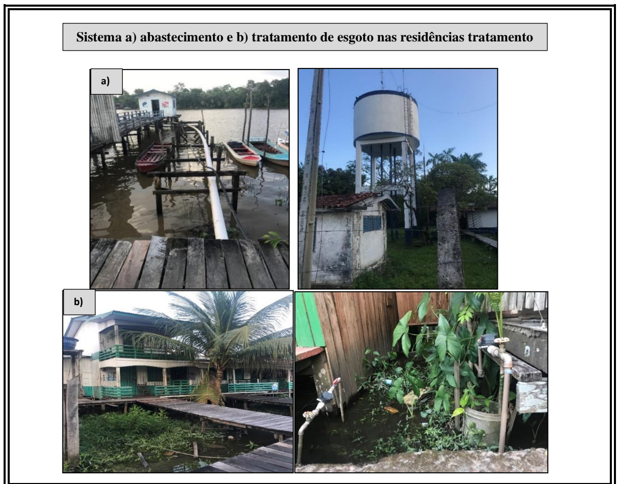
Figura 26 - Sistema de Abastecimento de Água- Afuá-PA.
