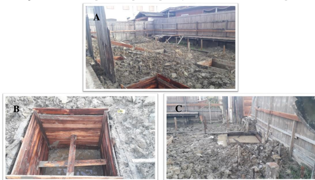
Figura 18 - Terreno perfurado para implantação de brocas estruturais e sapatas.
