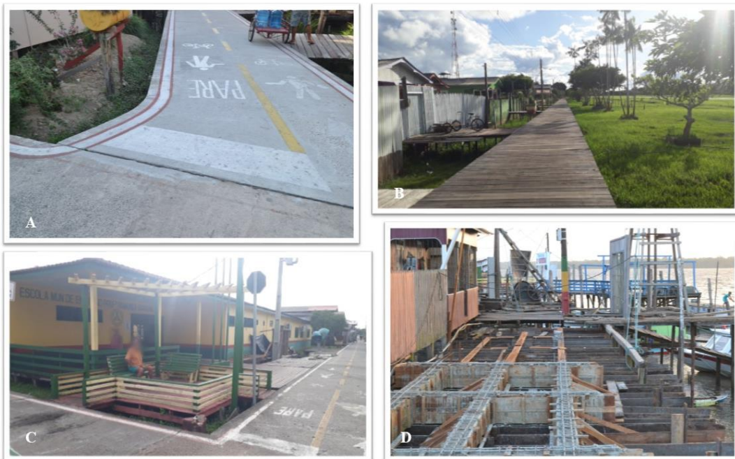
Figura 30 - Ruas suspensas em Afuá, “pontes ou palafitas”, em concreto armado no Centro (A, C e D), em madeira no Capim Marinho (B).
