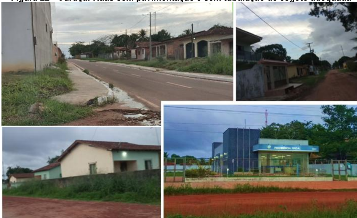
Figura 22 - Curuçá: Ruas sem pavimentação e sem tubulação de esgoto adequada
