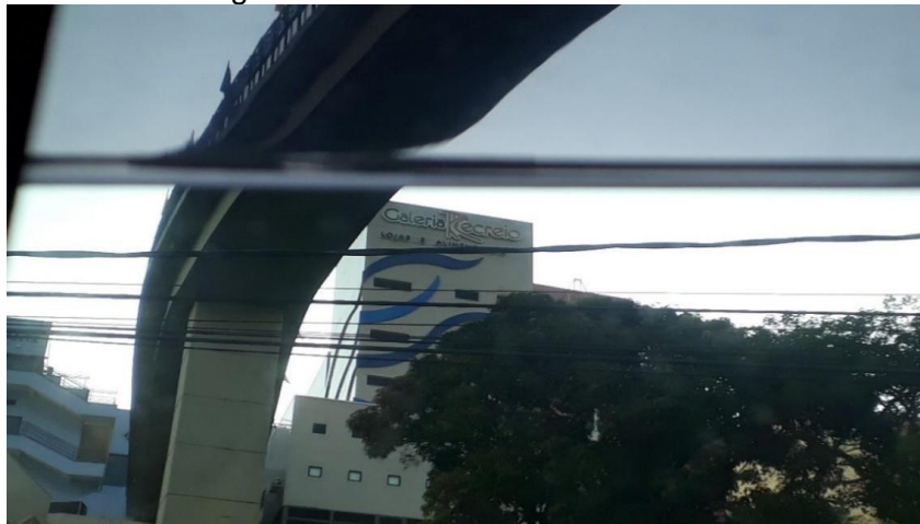
Figura 40 - Galeria Recreio finalizada
