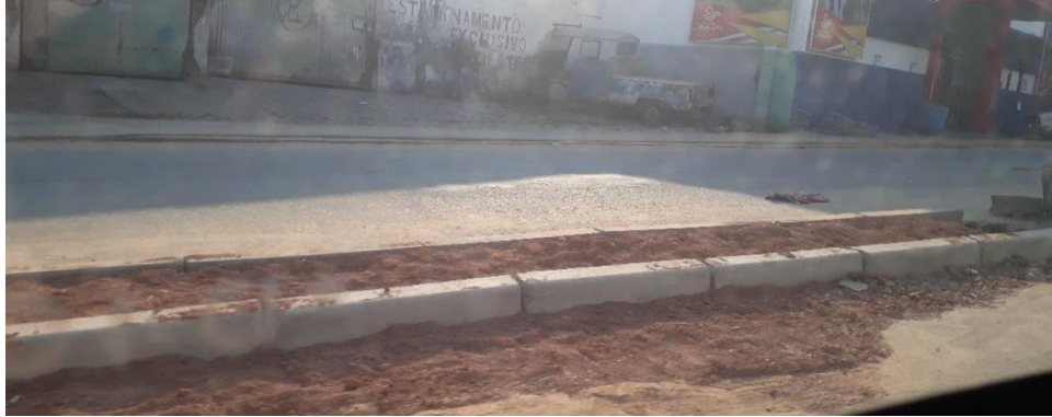
Figura 45 - Construção canteiro central
