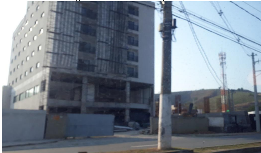
Figura 50 - Obras em Aparecida
