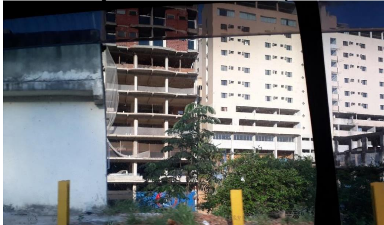
Figura 49 – Prédio em construção
