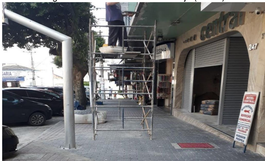
Figura 48 - Obra em fachada de loja (centro)
