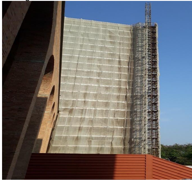
Figura 37 - Obra na fachada do Santuário
