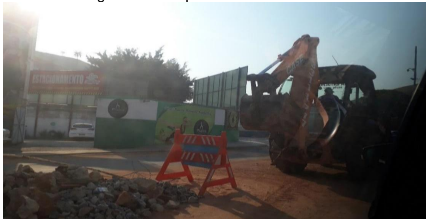
Figura 46 - Máquinas no canteiro central
