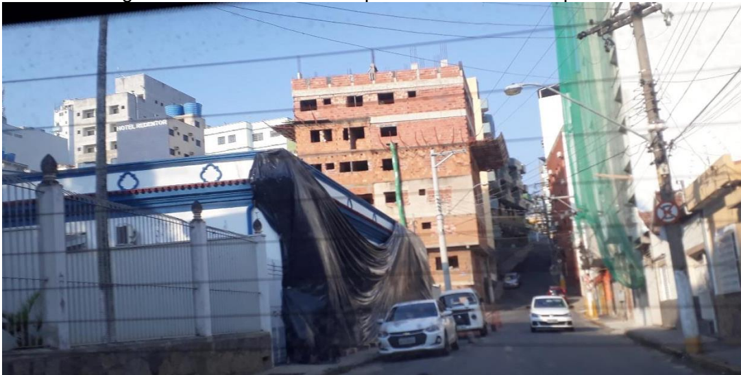
Figura 51 - Obras em rua do perímetro central de Aparecida
