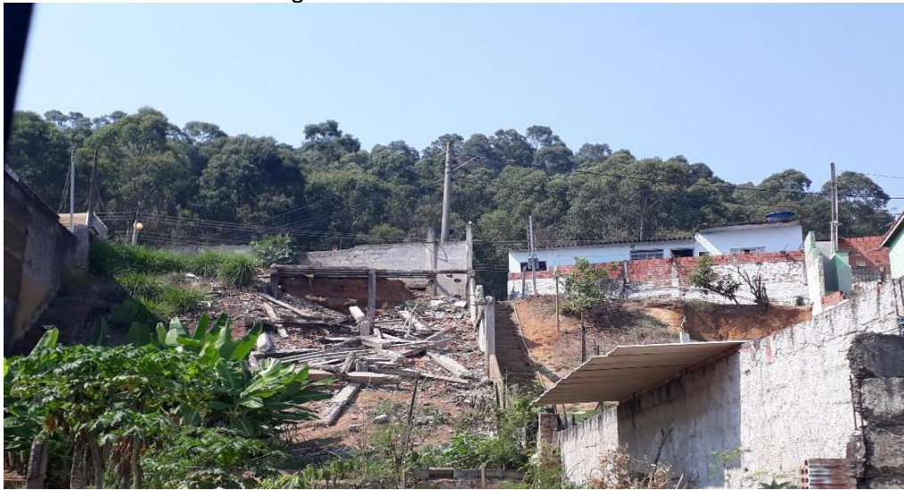
Figura 69 - Terreno com entulho
