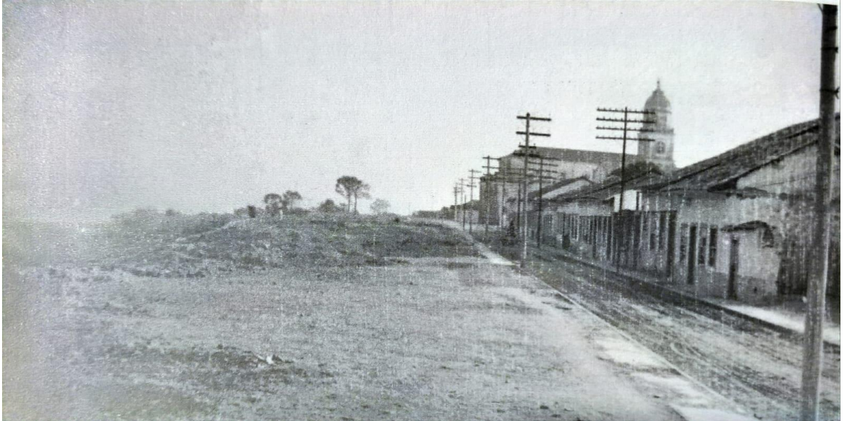
Figura 8 – Rua São José, com as residências do lado par já demolidas (1944).
