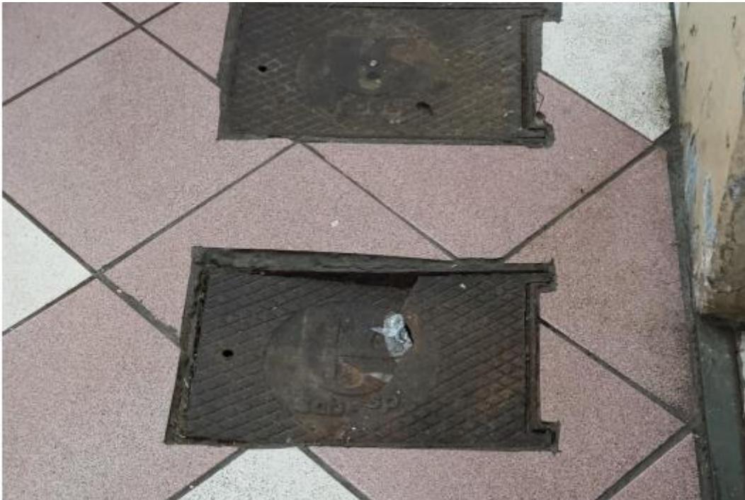
Figura 38: Caixa de inspeção do Mercado Municipal de São Jose dos Campos
