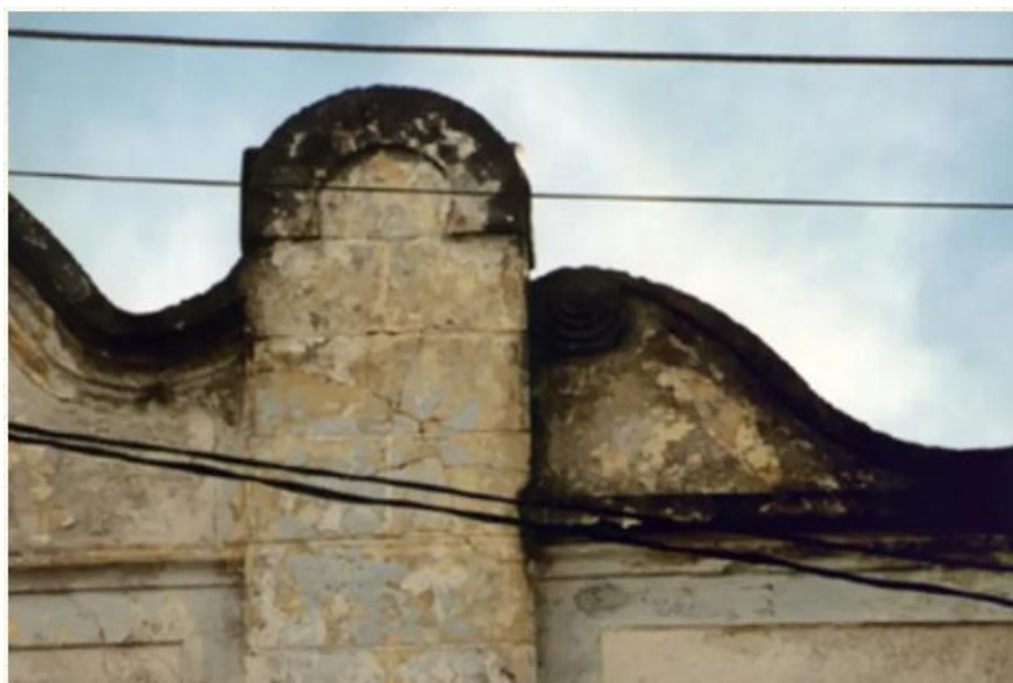
Figura 29: Mercado Municipal de São José dos Campos antes da reforma
