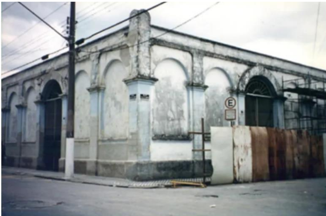
Figura 27: Mercado Municipal de São José dos Campos antes da reforma
