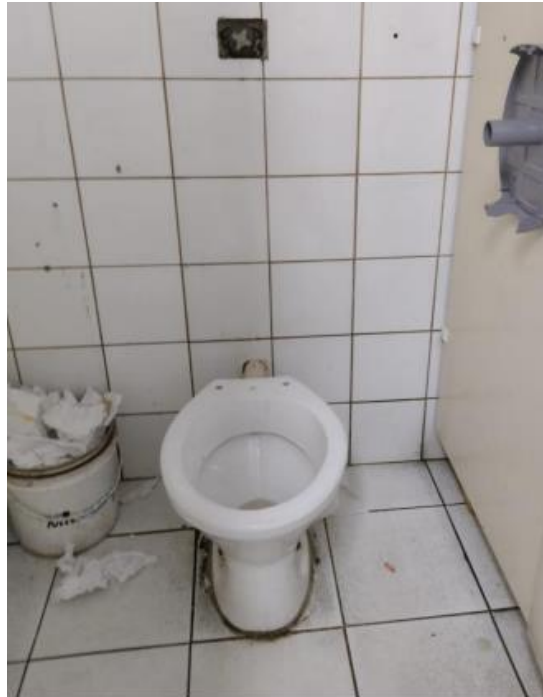
Figura 36: Banheiro Masculino do Mercado Municipal de São Jose dos Campos
