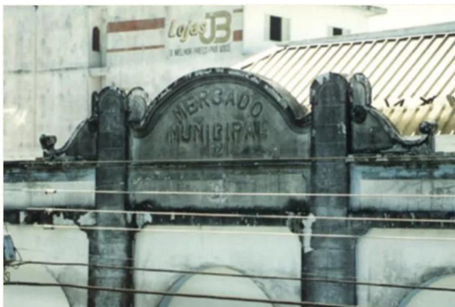
Figura 28: Mercado Municipal de São José dos Campos antes da reforma
